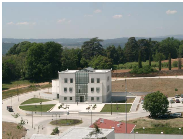
Figura 5 - Edifício da Câmara.
